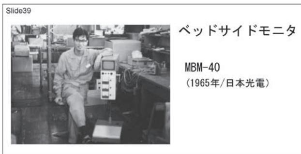
これは私の写真で、1965年に作り上げたベッドサイドモニタです。心電図や心拍数、呼吸数、体温をメーターで出していました。心電図も出ますが、すぐ消えてしまうものでした。それでも臨床用のモニタとしては初めて開発されたものでした。
